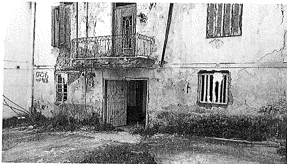
Φωτ. 4 Ο μεταγενέστερος εξώστης από σκυρόδεμα
