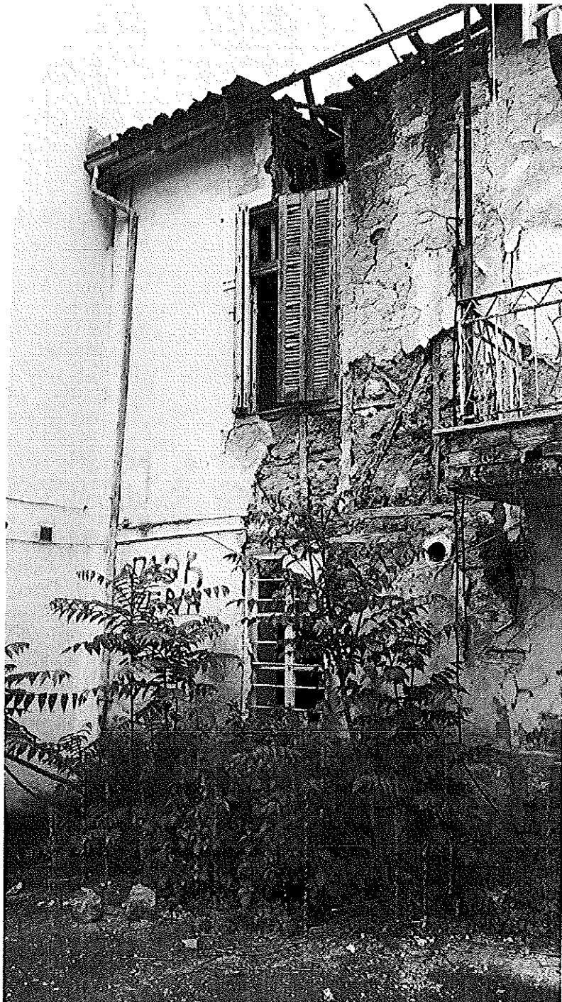
Φωτ. 3 Λεπτομέρεια της πρόσοψης
